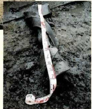
掘り出されたH鋼杭▲
