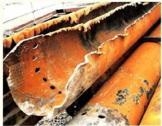
掘り出された鋼管杭▶
