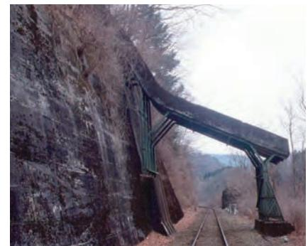
沢入駅から下り線で約4分、原向駅から上り線で約3分半で見えはじめます。ここは沢入みかげと呼ばれる花崗岩(かこうがん)の山肌が線路に迫る場所です。この架樋は、風化した花崗岩が線路に流れ込まないようにするためにかけられた施設です。長さ14mのコンクリートの樋を古いレールの柱で支えています。
