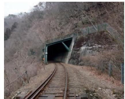
沢入駅から下り線で約2分、原向駅から上り線で約6分半で見えはじめます。トンネル両側の入口は、落石から線路とトンネルを守るため造られた落石覆い(おおい)でよく見えませんが、側壁を切石積み、天井を煉瓦積みにしたトンネルで、全長32mです。沢入駅側の落石覆いの一部は古いレールを支柱にしています。
