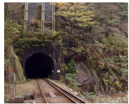
沢入駅から下り線で約5分半、原向駅から上り線で約2分で見えはじめます。トンネルは全長362mで、入口部分は、アーチ部分を煉瓦積み、側壁部分を切石積みとしています。旧足尾鉄道として建設されたトンネルの中では、最も長いトンネルです。
