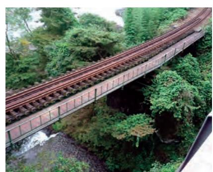
上神梅駅から下り線で約2分、本宿駅から上り線で約30秒で見えはじめます。全長30m、2連の橋桁（はしげた）が2基の橋台（きょうだい）と1基の橋脚（きょうきやく）の上ののる上路式プレートガーダー形式の橋で、コンクリート製の本宿駅側の橋台は、カスリーン台風から復興したときのもので昭和23年に造り替えられたものです。
