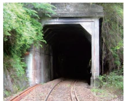
上神梅駅から上り線で約2分半で見えはじめ、第三神梅トンネルから第一神梅トンネル・手振山架橋までの通過時間は約1分です。建造当初の第三神梅トンネルの内部は馬蹄形で煉瓦積み45mでしたが、昭和12年に箱形コンクリート造の落石覆いが設けられ、全長60mとなりました。
