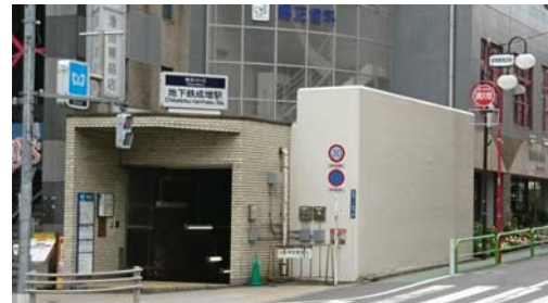
地下鉄成増駅 4番出入口付近
