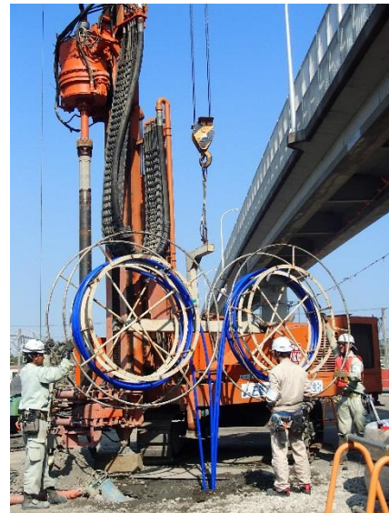
写真1 熱交換チューブ設置作業 (総合研修センター（仮称）)
