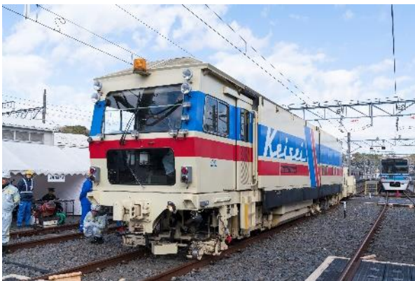
突き固めを行うマルチプルタイタンパー
