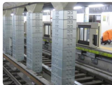
▲トンネル中柱補強
