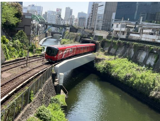
丸ノ内線 御茶ノ水橋りょう
