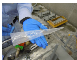
② 充填材を製造し、充填袋に詰め込む。
