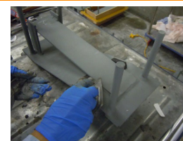
④ 側面から溢れた充填材をコテなどで均す。
