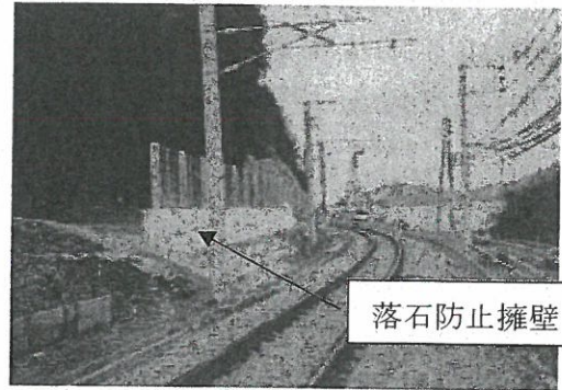
【落石防止擁壁の一例】
