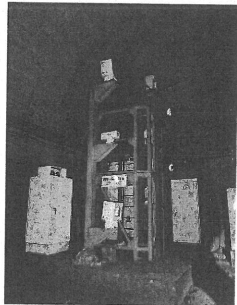
【火災検知装置の例】
