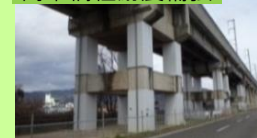
高架橋柱耐震補強
