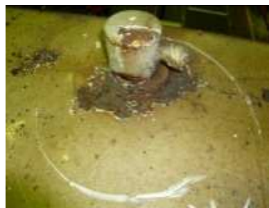
屋根鋼板腐食
