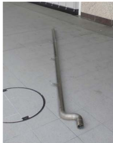
転倒した排水パイプ
