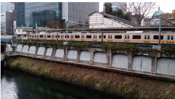
盛土耐震補強
