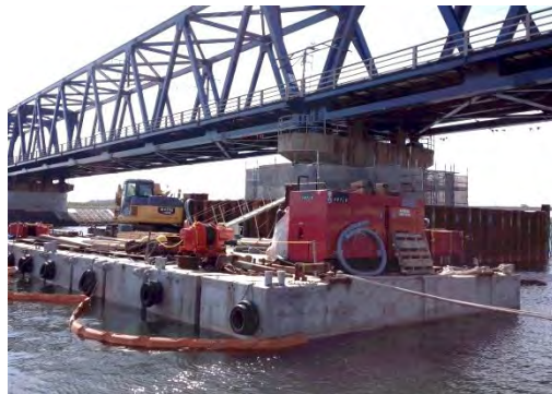
橋脚耐震補強
