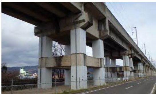
高架橋耐震補強
