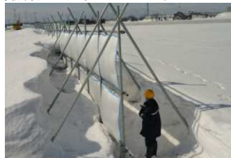
防雪柵の状況
