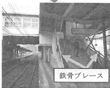
【橋上駅の補強】
