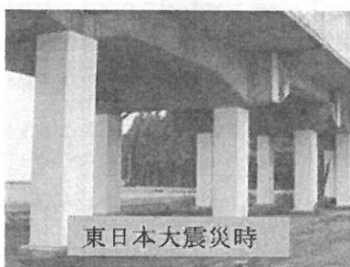
【高架橋の補強】
