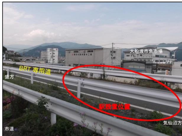
駅設置位置写真
