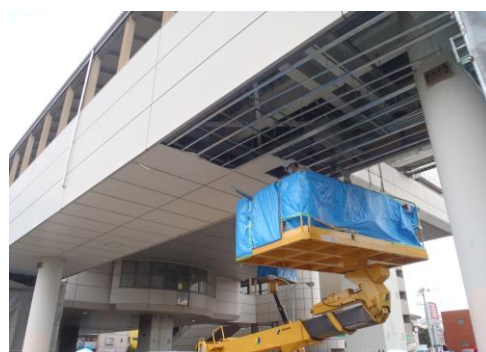
通路部軒天井修繕工事状況
