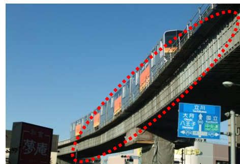
鋼軌道桁塗装用足場設置状況
