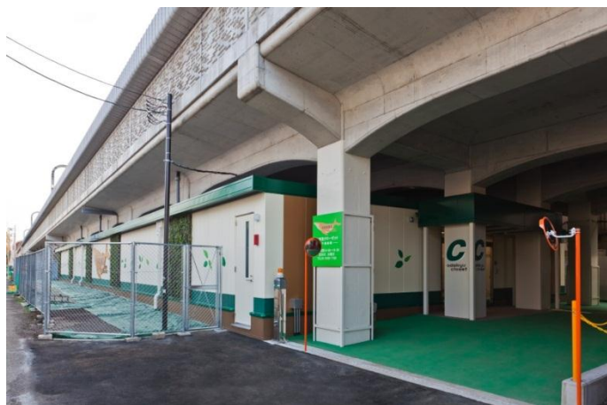
高架下に建設される「小田急クローゼット」外観 (写真は、小田急クローゼット千歳船橋C棟)
