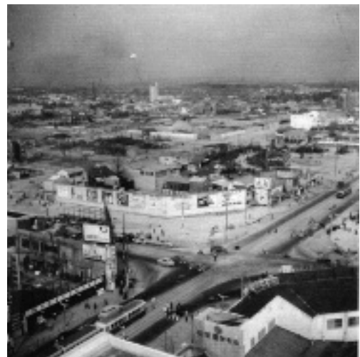
写真-3-1 地下鉄建設前の栄町交差点付近 1954（昭和29）年3月
