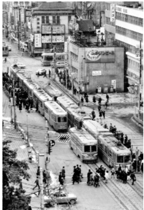
写真-5-1 地下鉄建設工事中の市街地
