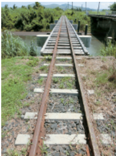
写真-47 バ〜ラウトカ間にある洪水後に復旧された橋梁。取り付け部分の軌道には、短いコンクリート枕木が使用されている。（2014年2月24日）
