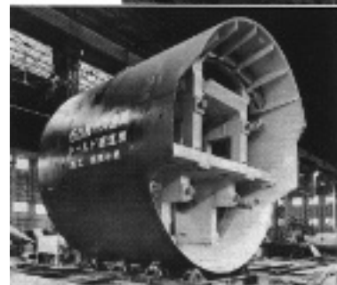
写真-3-9、写真-3-10 日本の地下鉄で初の円形シールド工法でトンネルを掘削
