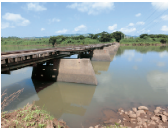
写真-42 広いバ川(川幅約300m)に架かるサトウキビ鉄道用の鋼桁製橋梁は、フィジーで一番長い橋梁である。(西を見る。2014年2月24日)
