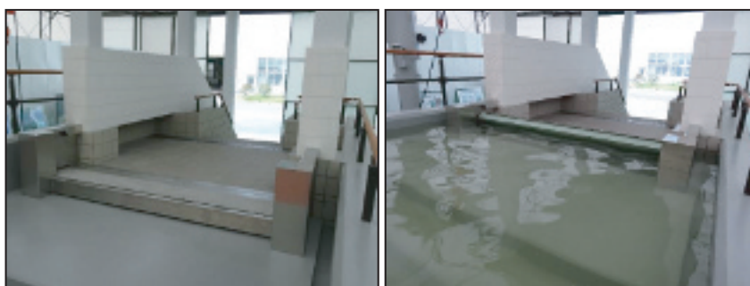
平常時 浸水時 図4 地下鉄出入口へのneo RiSe設置イメージ
