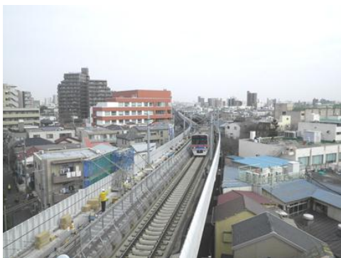
▲下り線で軌道工事及び電気工事中の墨田区内連続立体交差化工事
