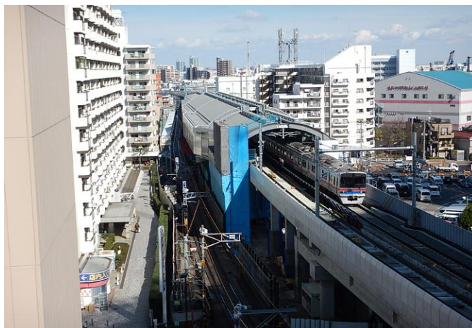
下り線で軌道工事及び電気工事中の京成曳舟駅
