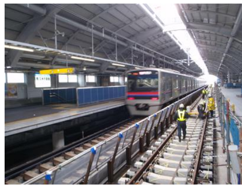
▲下り線で軌道工事及び電気工事中の墨田区内連続立体交差化工事
