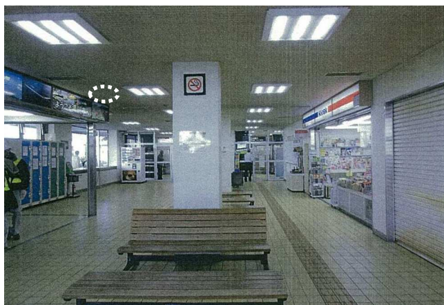
滝川駅 待合室 (●●●: 落下箇所)
