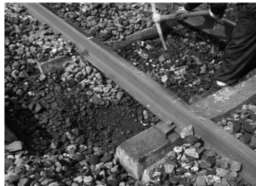
図5 道床バラスト掘り起こしによる確認
