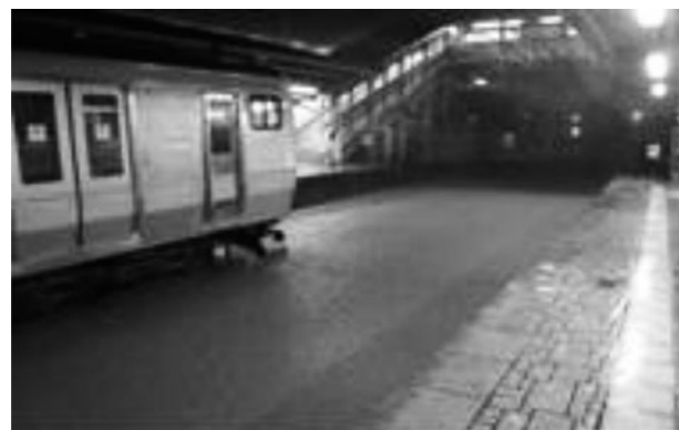
図3 極端豪雨による駅構内冠水被害
