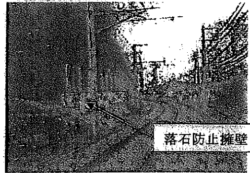
【落石防止擁壁の一例】
