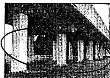
鋼板を巻く耐震補強により倒壊の被害なし
