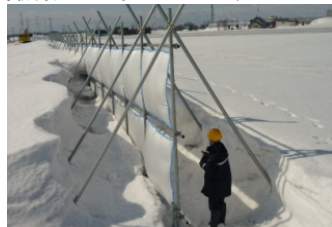
防雪柵の状況
