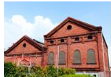
尼崎車庫のれんが倉庫
