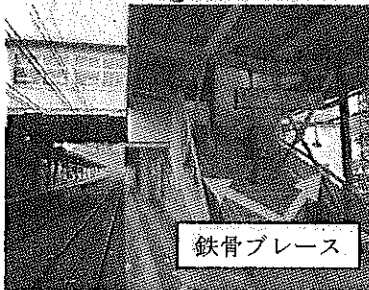
【橋上駅の補強】
