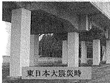
【高架橋の補強】
