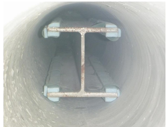
芯材として H 鋼を挿入した例
