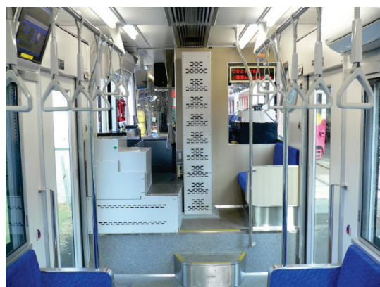
車内のバッテリー配置状態
