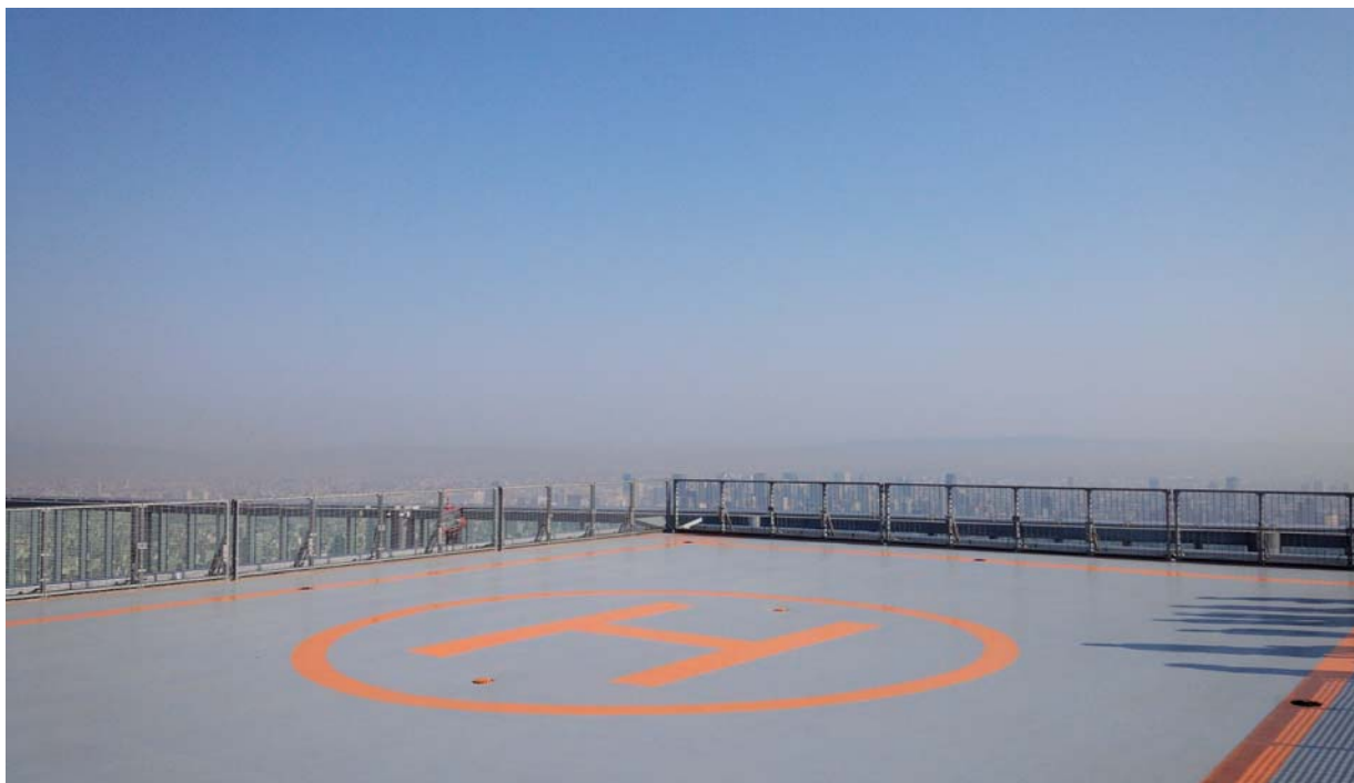
「あべのハルカス」ヘリポート写真（平成26年4月撮影）
