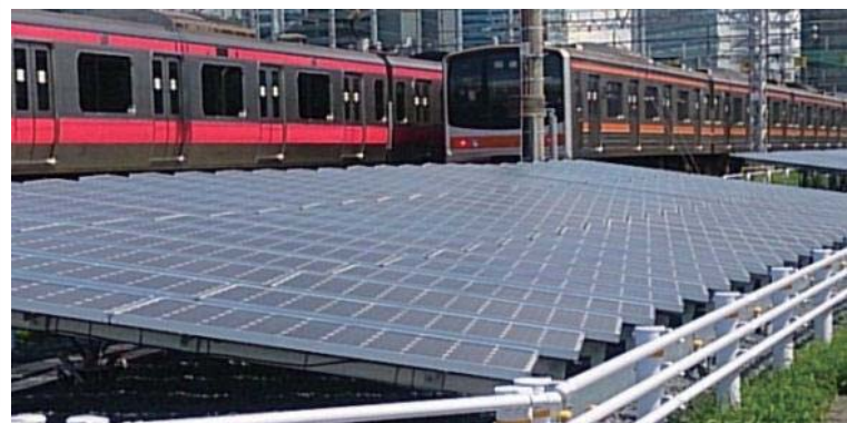
太陽光発電設備
