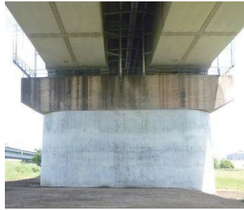
橋脚耐震補強
