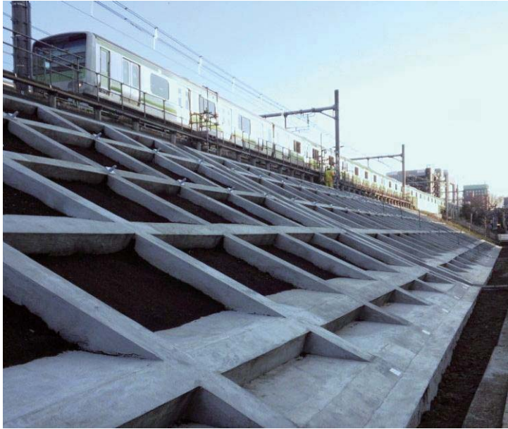
盛土耐震補強
