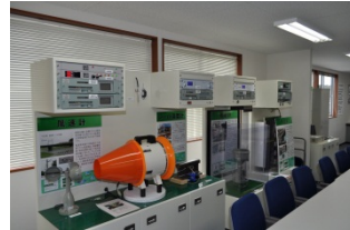
災害検知装置等 (防災研修棟)
