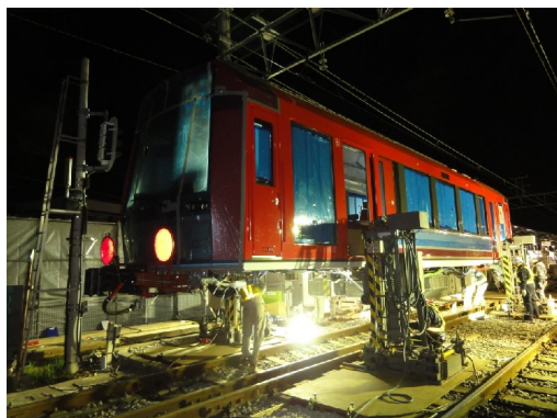
車両搬入作業の様子
