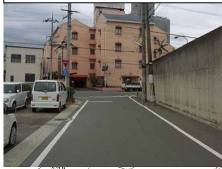
① 市道⇒府道京都守口線交差点部を望む (道路については拡幅工事中)
