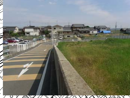
⑨ 跨線橋付近の状況
