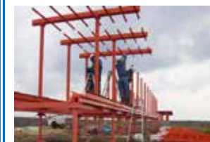
老朽化したILS(計器着陸装置)の更新
