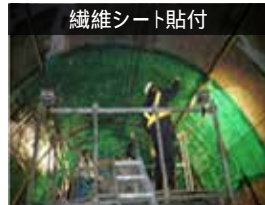
繊維シート貼付
