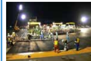
老朽化した滑走路の舗装打ち替え
