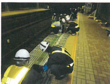
ベースプレートの設置
