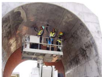
トンネル検査訓練（土木）
