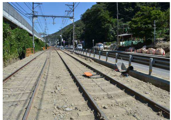
土砂撤去作業後の状況
