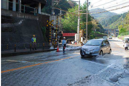
上関寺国道踏切(国道 161 号線)の状況
