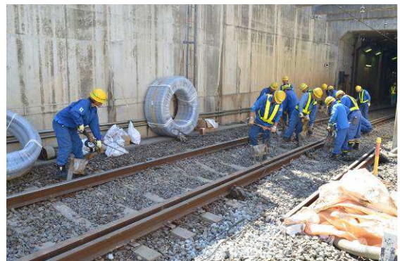
軌道整備作業の様子
