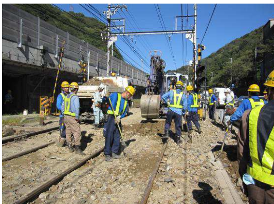
土砂撤去作業の様子
