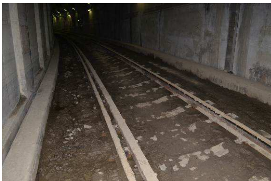
排水後の汚泥の状況
