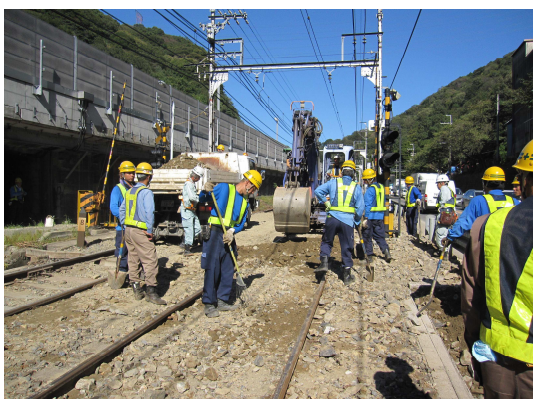
土砂撤去作業の様子
