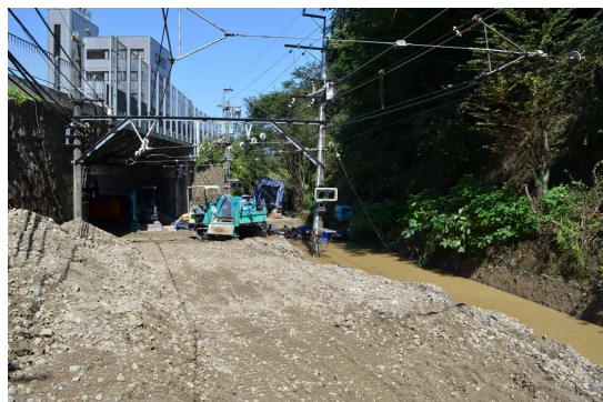
国道1号線交差部の状況(大谷駅側より)
