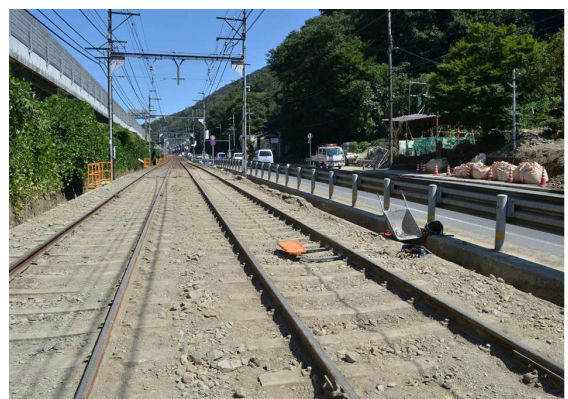
土砂撤去作業後の状況
