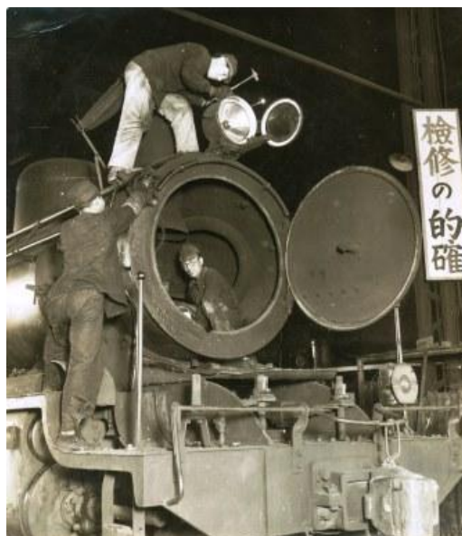
▲ 蒸気機関車の検修作業の様子 1950(昭和25)年
