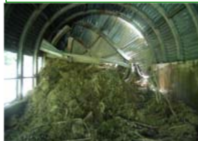
89k700m付近、89k820m付近 土砂流入
