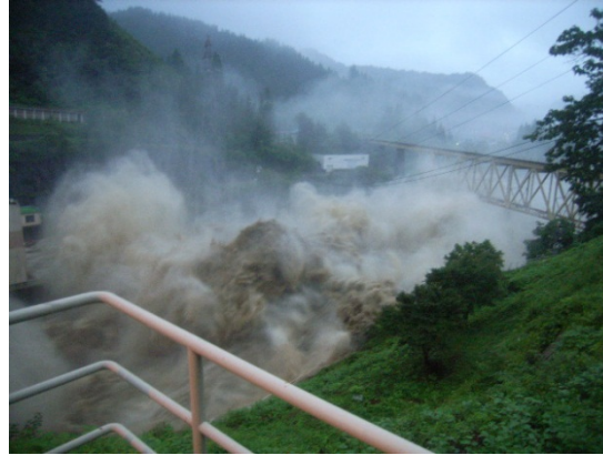
《被災直後》 3径間(約115m)流失
