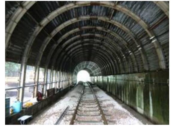
89k820m付近(第1赤沢雪覆い工) (施工後)
