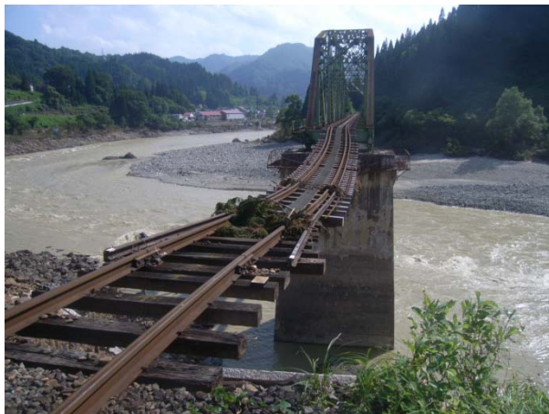
会津川口側から撮影
