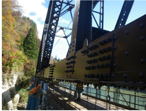
第4只見川橋りょう(施工後)
