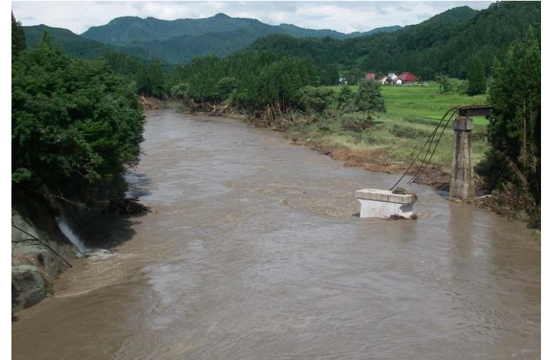
《被災直後》 2径間(約100m)流失
