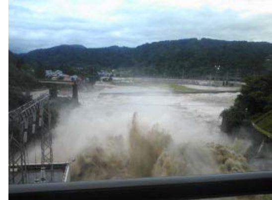
《被災直後》 3径間(約115m)流失
