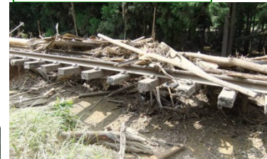
55k030m付近 路盤流失 55k060m付近 土砂流入
