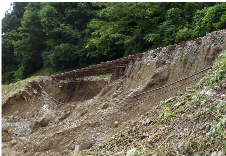
信号通信ケーブル損傷
