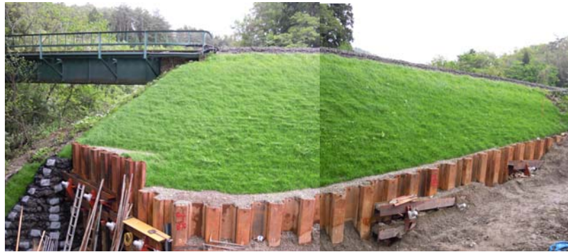
30k700m付近 盛土復旧(施工後)
