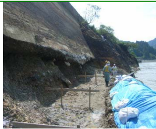
59k910m、60k450m付近 護岸壁洗掘
