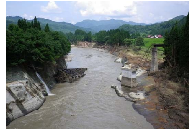
橋桁流失状況
