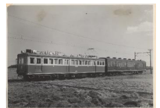
▲クハ5901形 交直両用電車試作車
