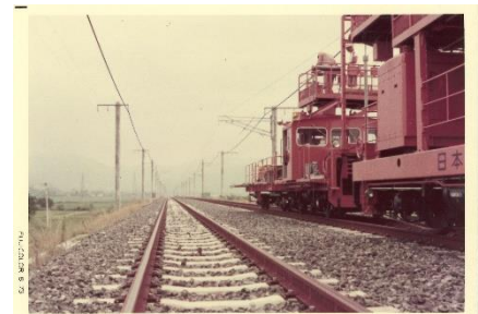
▲「湖西線新設工事(マキノ〜新旭付近)」 1973 (昭和 48) 年
