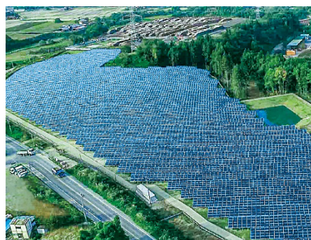
リエネ会津太陽光発電所
