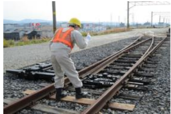
駅係員の転てつ器手動操作訓練
