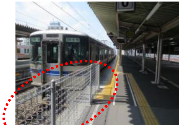
岡崎駅のホーム転落防止柵
