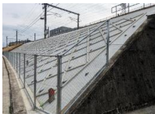
のり面改良（北野柵塚駅～三河上郷駅間）
