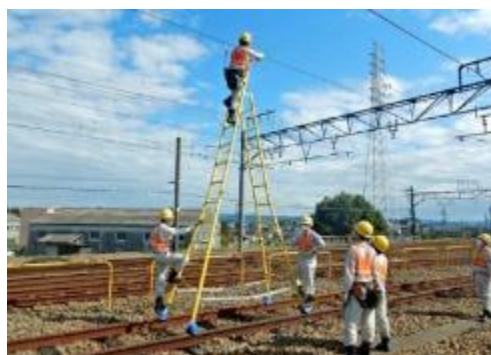
電車線の修復訓練
