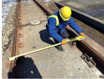
軌道検測作業風景
