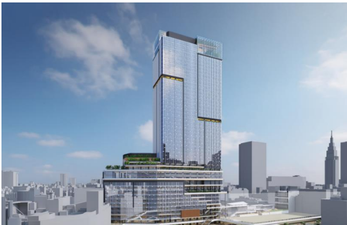
西側から見た計画建物のイメージ (2022年2月9日時点の設計に基づく)
