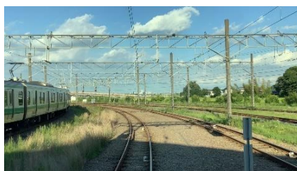
川越車両センター構内
